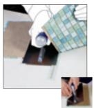
Pour les mosaïques montées sur papier, préparez le matériel. Coupez des bandes de tesselles en suivant le veinage du papier. Utilisez une spatule lisse. Le support doit être coupé très soigneusement. Laissez un petit morceau de papier sur les tesselles de façon à pouvoir les déplacer et les adapter aux surfaces arrondies.
